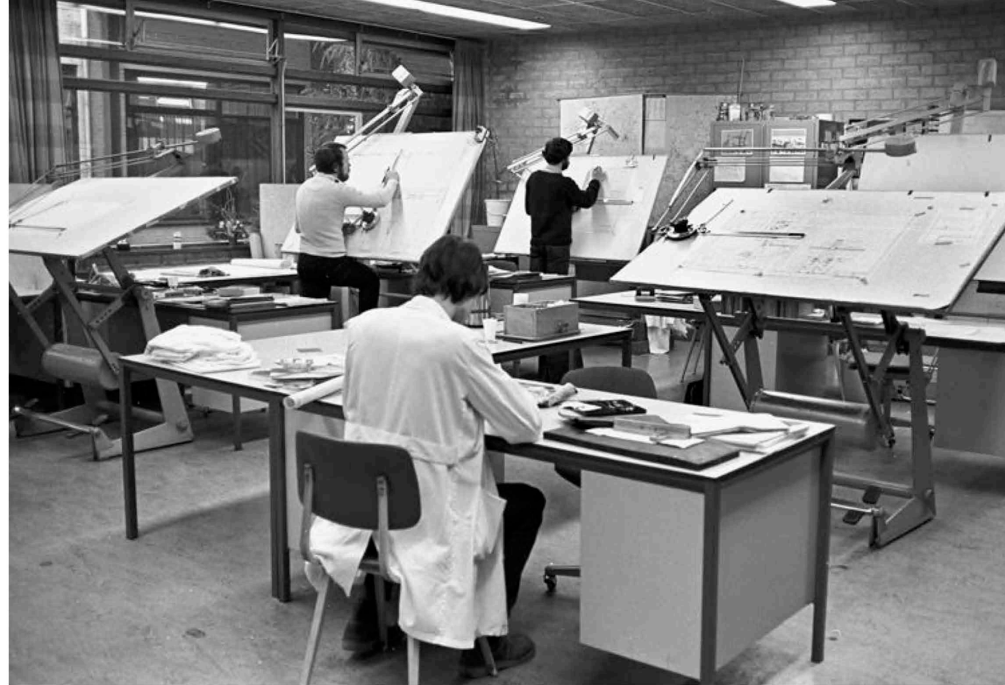
Tekentafels bij technisch installatiebedrijf Alewijnse in Nijmegen.
