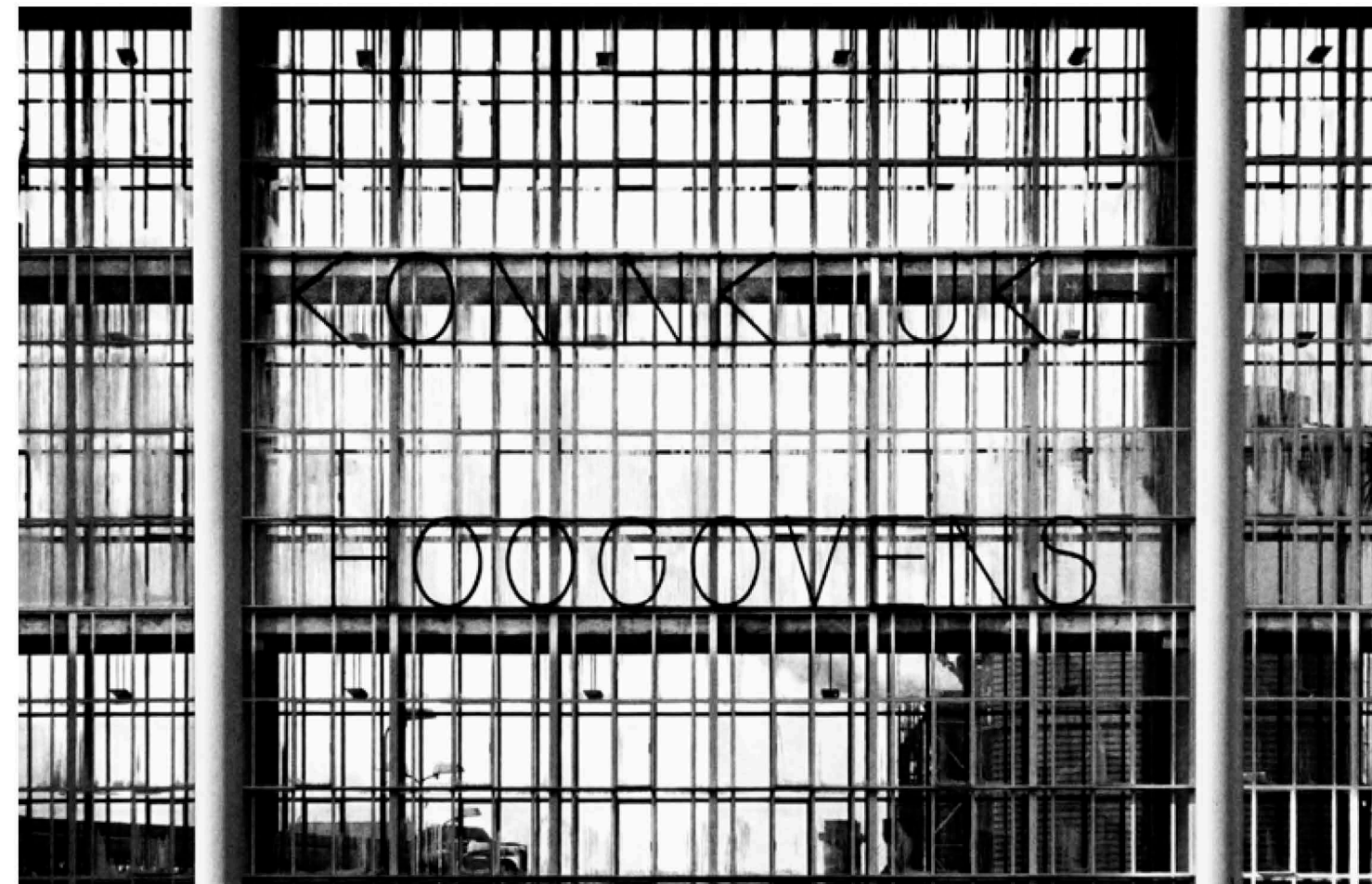
Toegang tot de koninklijke hoogovens in IJmuiden. Ontworpen door architect Dudok.
